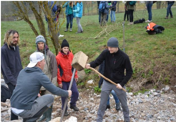
Einbau von Steckhölzern am Bachufer
