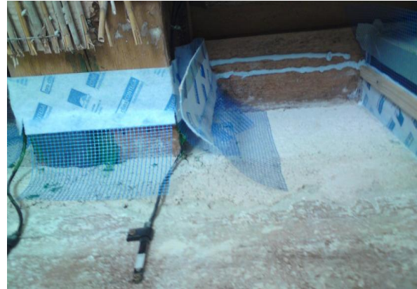
OeKO-ID Innendämmung zur thermischen Gebäudeertüchtigung - © Einreicher
