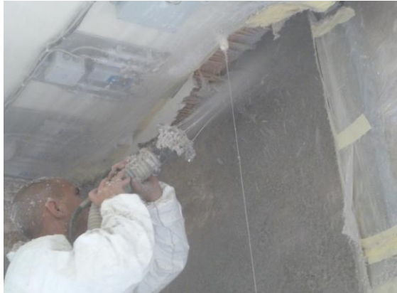
OeKO-ID Innendämmung zur thermischen Gebäudeertüchtigung - © Einreicher
