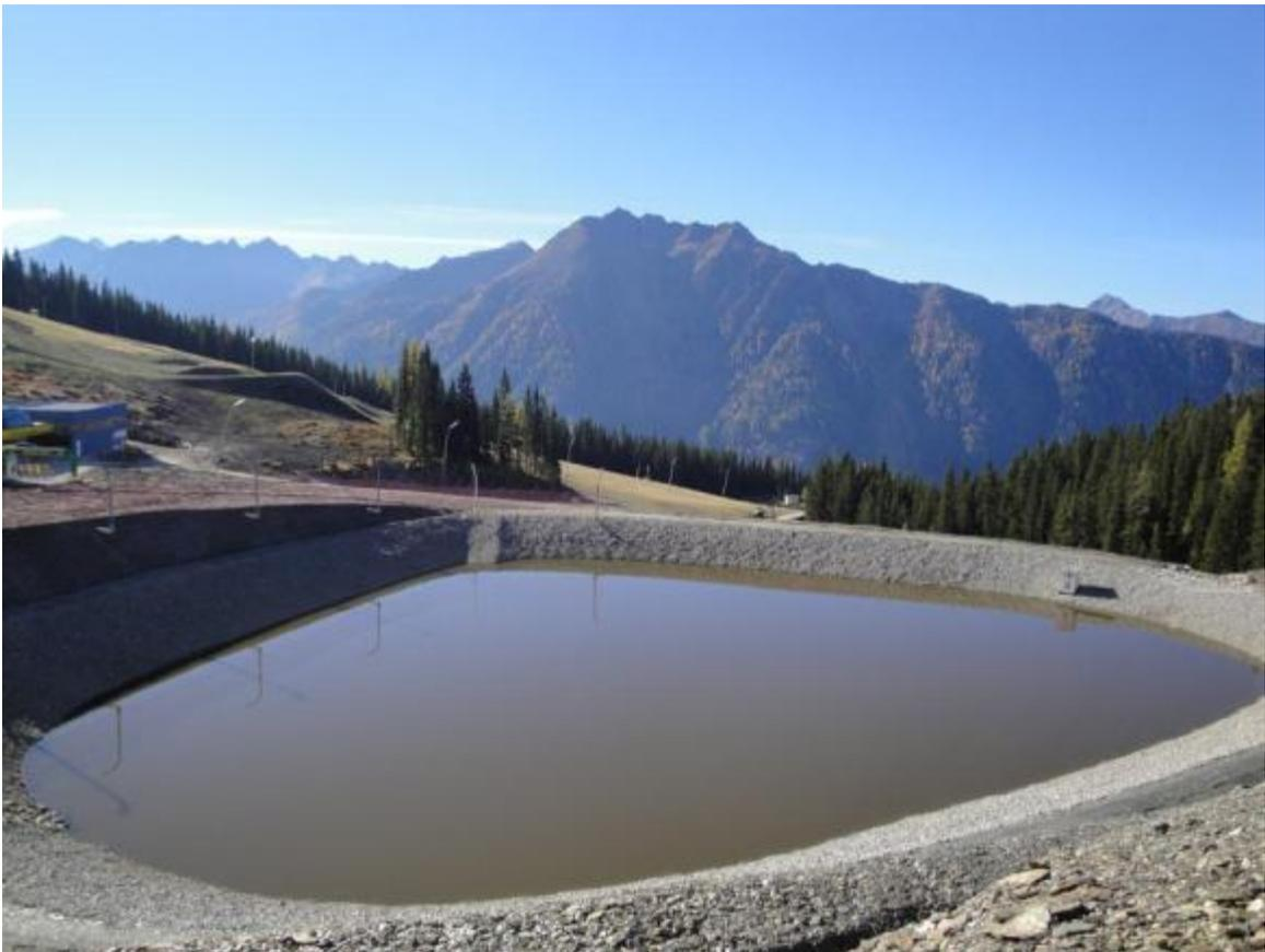
Bildtext: Der neue Speicherteich stellt eine Grundbeschneigung des Gipfelbereiches in 50 Stunden sicher.
