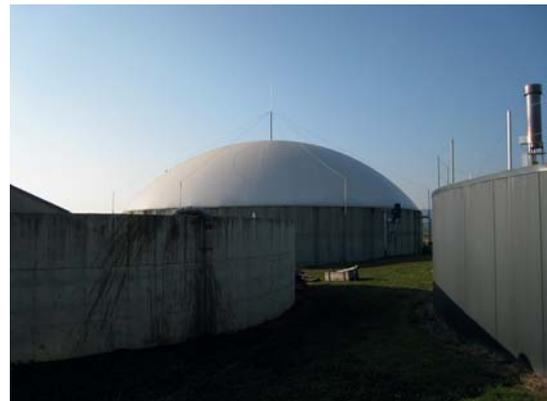
Abbildung 45: Biogasanlage/Gärbehälter mit Foliengasspeicher
